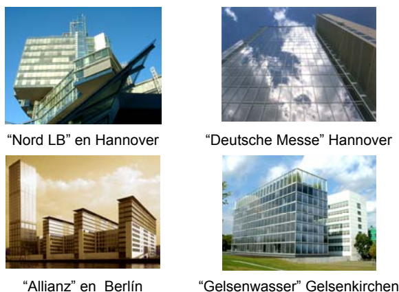
Figura 1 Algunos ejemplos de 25 edificios que se incluyen en este trabajo de campo.
